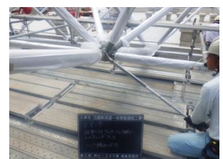
写真-7 本締め状況
