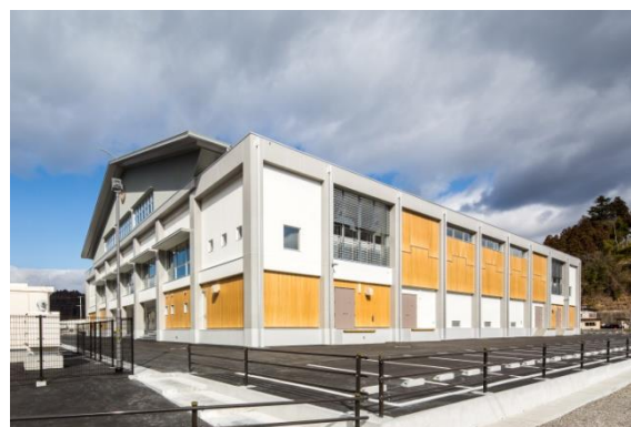
写真-2 建物外観（東西面）
