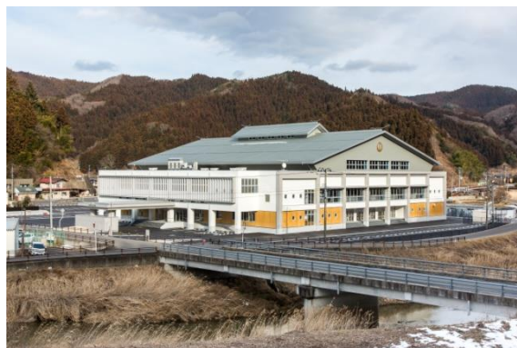
写真-1 建物外観（南西面）
