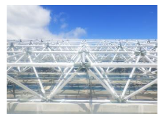
写真-8 TM トラス組立完了
