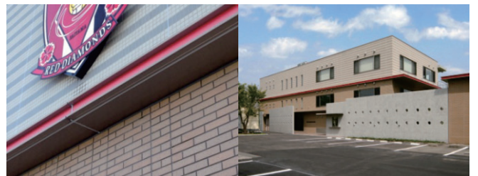
写真-3 外装タイル（既存棟）
