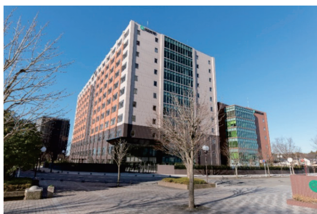
写真-1 南東側外観写真（京成電鉄 公津の杜駅前）
