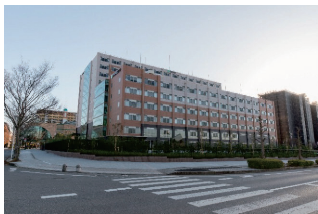
写真-2 北東側外観写真
