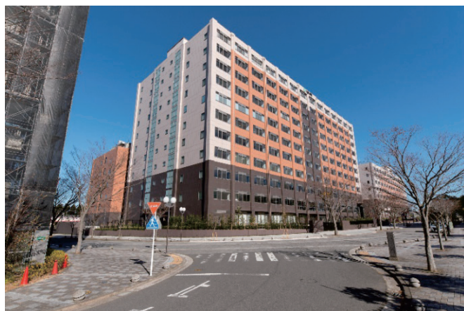
写真-3 南西側外観写真 (右奥にあるのが看護・保健医療学部)
