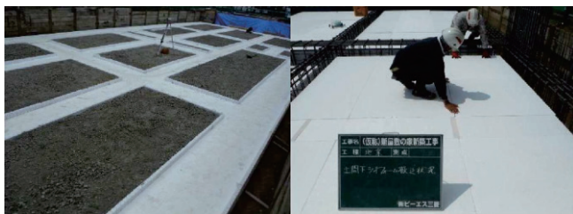
写真-2 ジオフォーム施工状況
