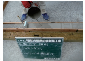
写真-3 レベリング施工状況
