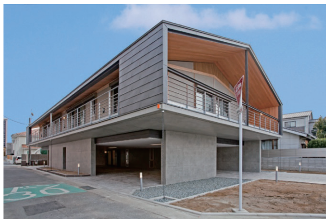
写真-1 建物外観
