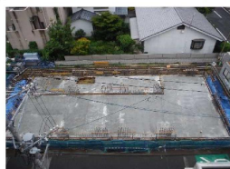
⑪基礎・1階スラブコンクリート打設
