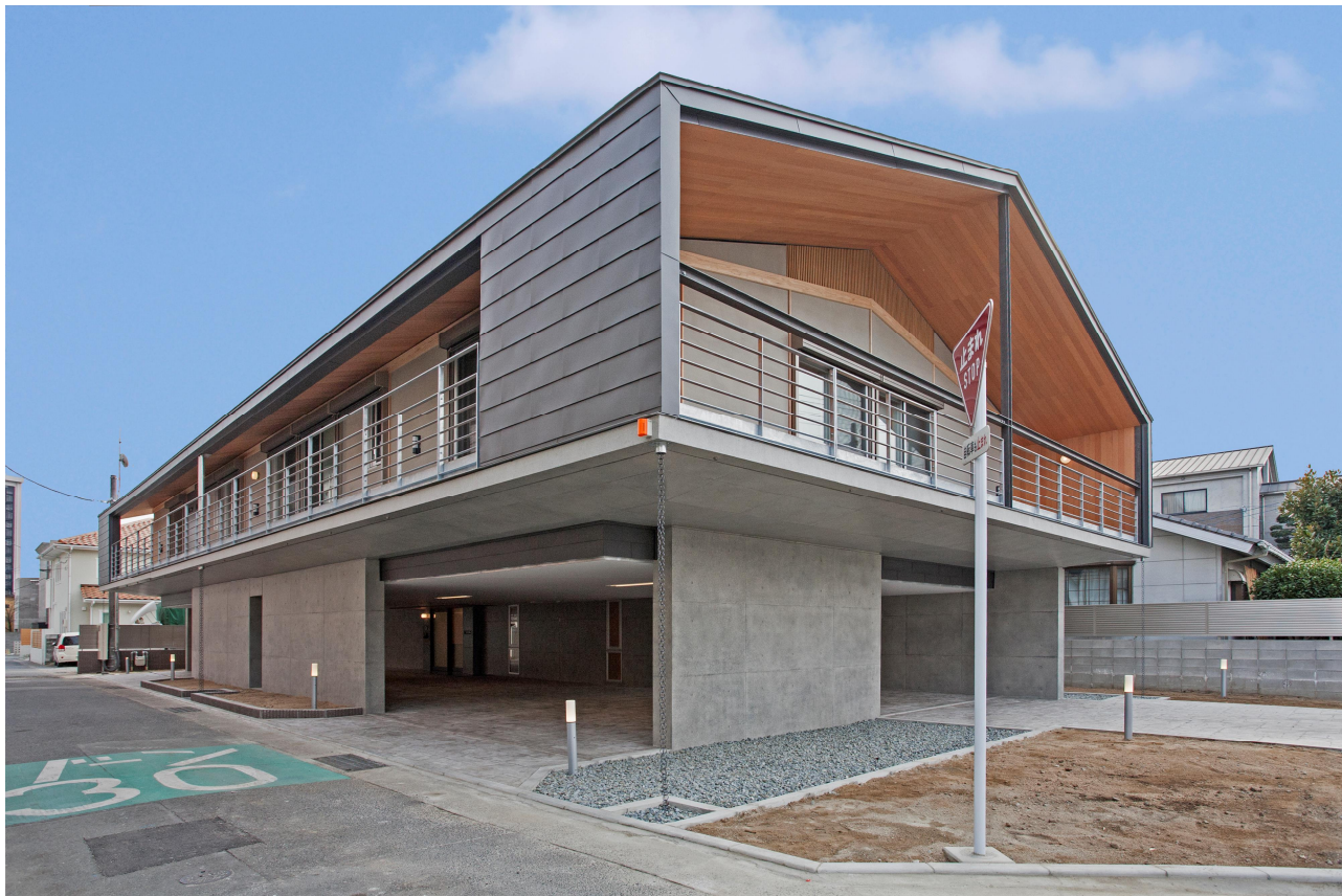
写真-1 建物外観
