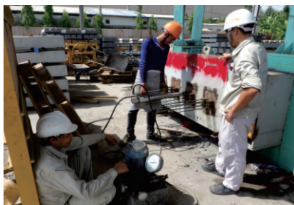
写真-3 PC 鋼線均等緊張
