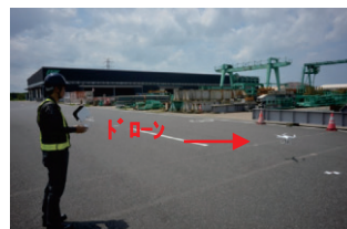
写真-3 測量状況
