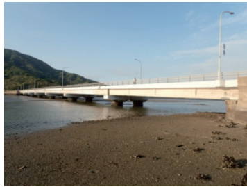
写真-1 弁天橋全景
