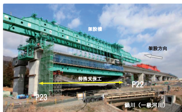
写真-3 特殊支保工を併用した架設状況
