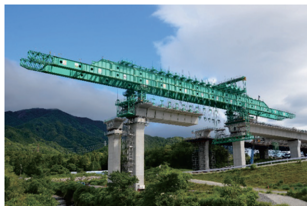
写真-1 スパンバイスパン架設状況
