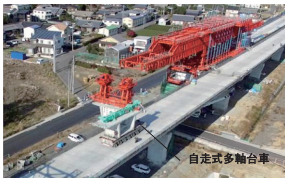
写真-2 橋上運搬状況
