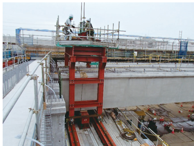
写真-3 特殊架設機
