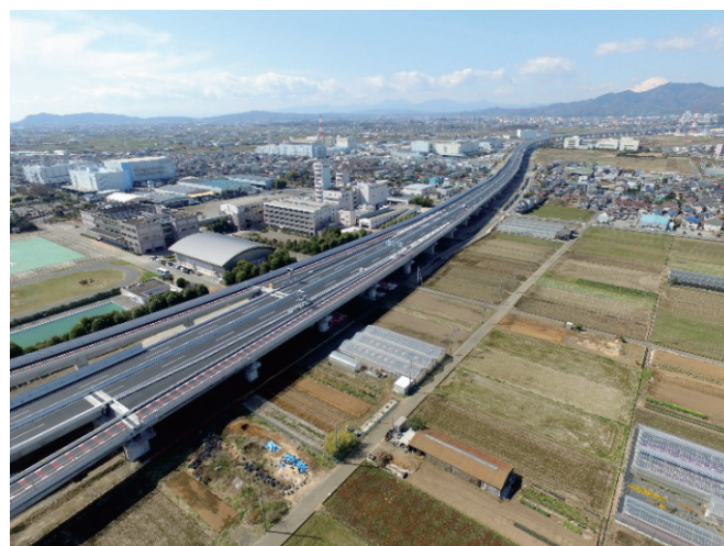
写真-4 完成写真
