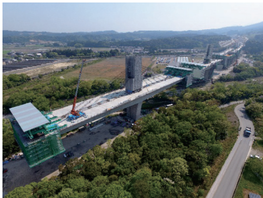
写真-1 エクストラードズド橋の施工
