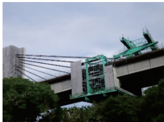
写真-2 移動作業車後退装置
