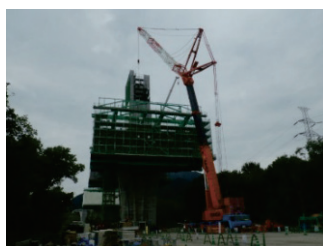
写真-3 鋼殻の据付
