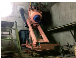
写真-6 斜材の緊張
