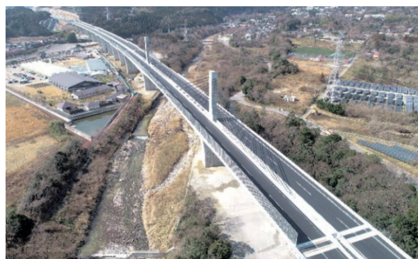
写真-8 完成写真
