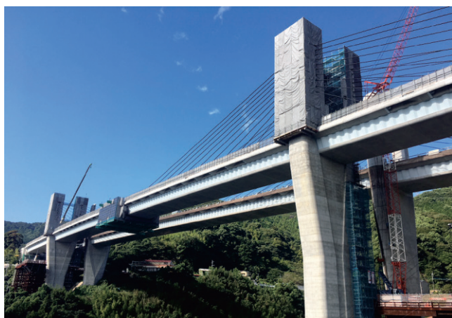
写真-1 施工状況全景
