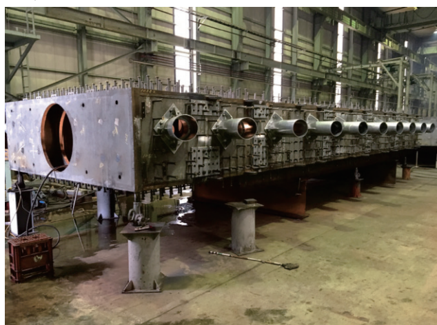
写真-2 鋼殻の製作状況
