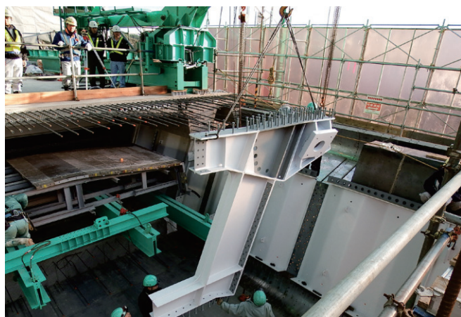
写真-3 鋼製隔壁の組立て
