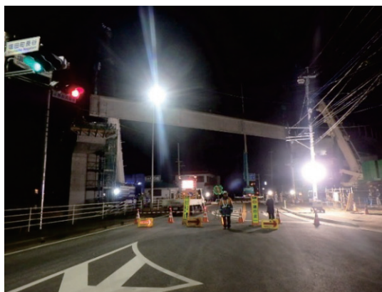
写真-3 主桁架設状況(クレーン相吊り架設)
