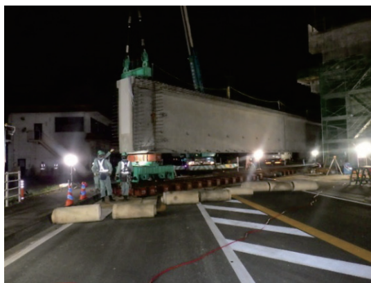
写真-2 自走台車による主桁の引出し状況
