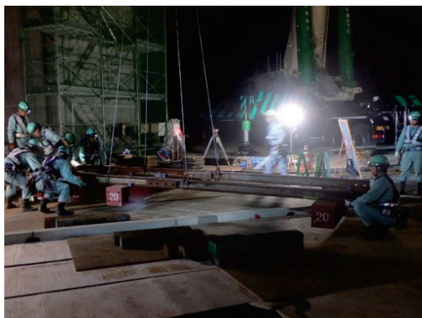
写真-1 国道へ軌条延伸状況
