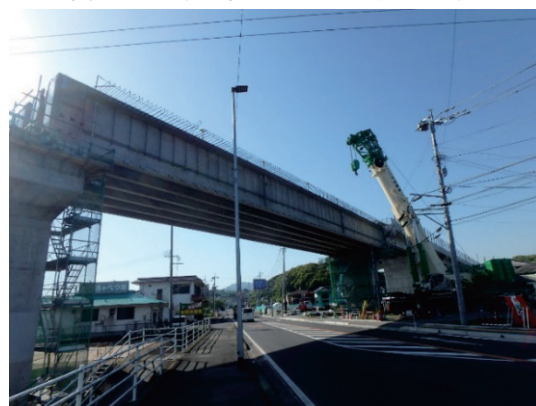
写真-4 主桁架設完了
