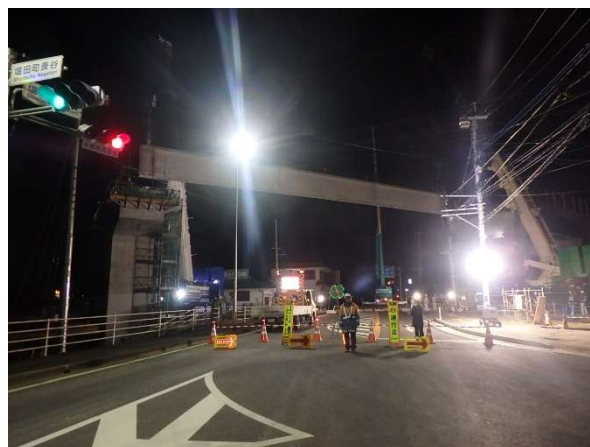
写真-3 主桁架設状況(クレーン相吊り架設)
