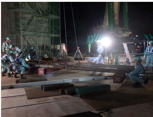
写真-1 国道上への軌条延伸状況
