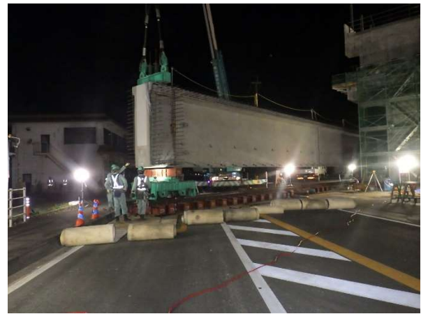
写真-2 自走台車による主桁の引出し状況
