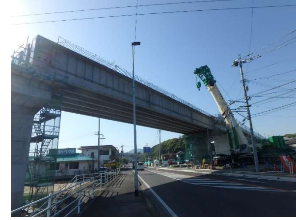
写真-4 主桁架設完了
