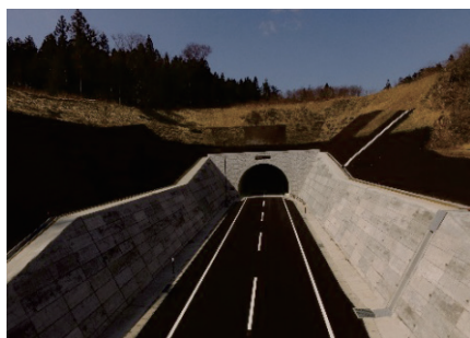
写真-1 起点側完成全景
