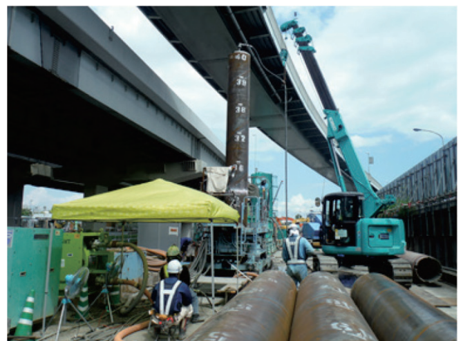
写真-1 PU4 橋脚 既製杭施工状況（上空制限部）
