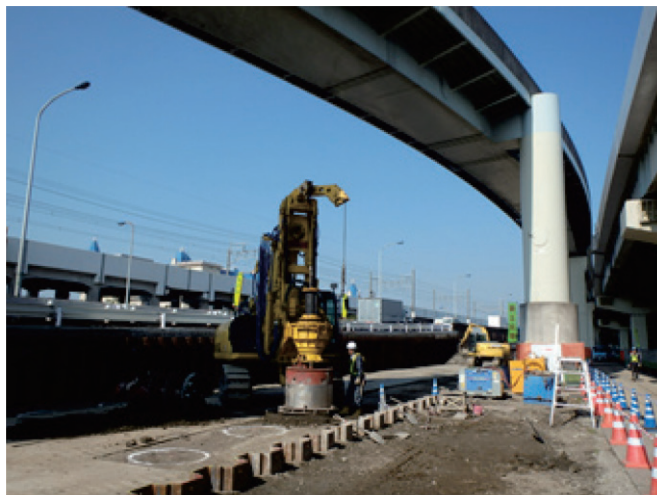
写真-2 PU4 橋脚 地中障害撤去状況：回転掘削工法 （上空制限部）
