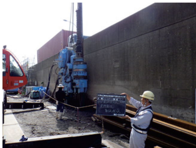
写真-4 PU2 橋脚 ゼロクリアランス工法施工状況 （硬質地盤型）
