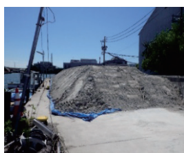
写真-5 ③汚泥蓄積
