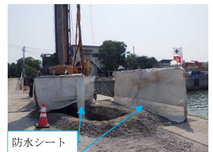
写真-6 河川側への飛散養生状況
