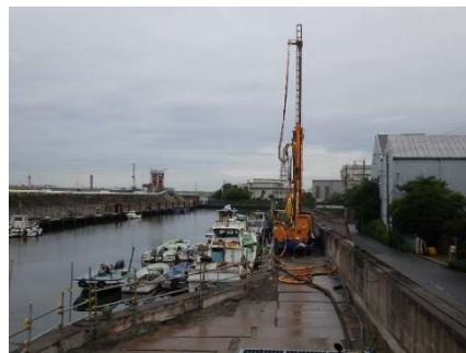
写真-4 ②低水位の時間帯を狙った施工状況
