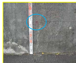
写真-2 監視測定基準を近接道路へマーキング（現舗装天より 500 上がり）
