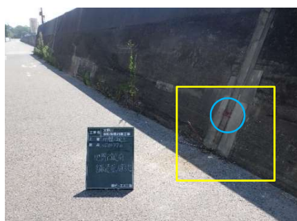
写真-2 監視測定基準を近接道路へマーキング（現舗装天より 500 上がり）
