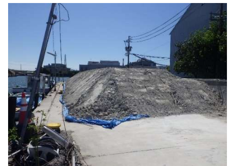
写真-5 ③汚泥蓄積
