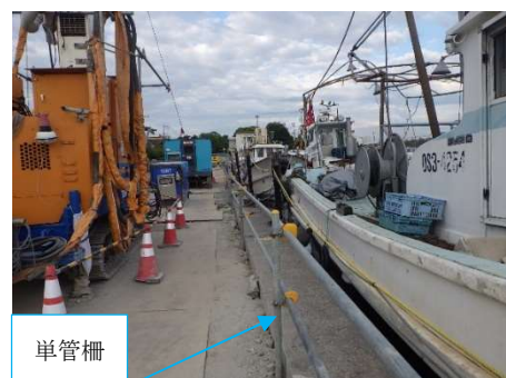
写真-7 単管による通路設置状況
