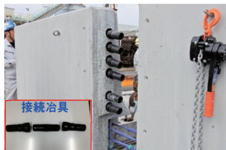
写真-3 管路接続治具設置状況
