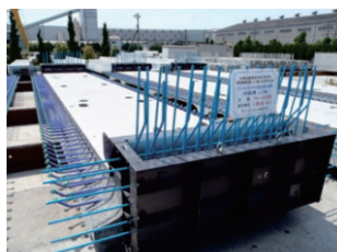
写真-1 地覆部の先行施工
