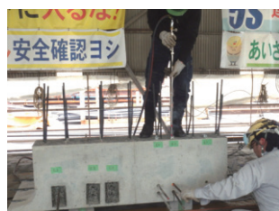
写真-5 切断状況
