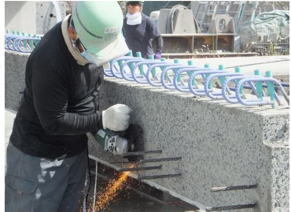
写真-2 PC鋼材端部の通常処理方法
