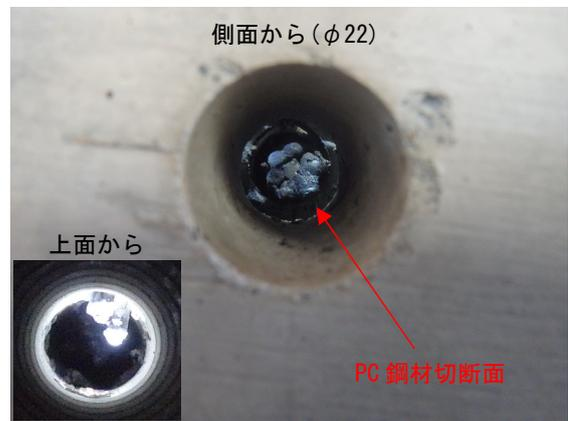
写真-10 切断後のPC鋼材
