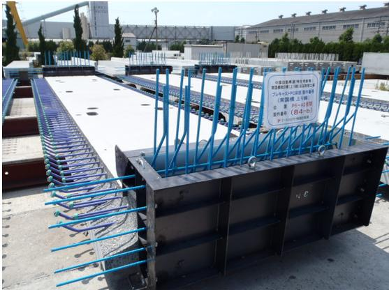
写真-1 PC床版の地覆部の先行施工
