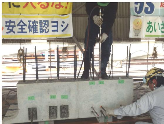
写真-9 ガス切断状況
