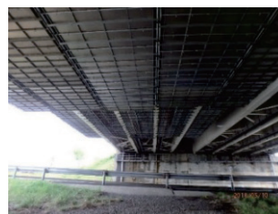
写真-2 ランプ道路上足場設置状況
