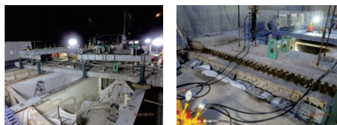
写真-3 伸縮装置撤去状況 (黒沢川橋)
