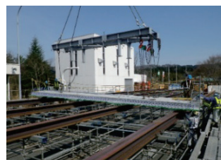
写真-1 仮組立て状況
