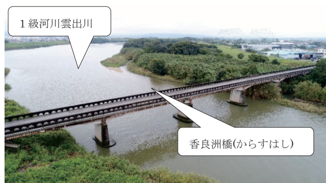
写真-1 香良洲橋と一級河川雲出川
