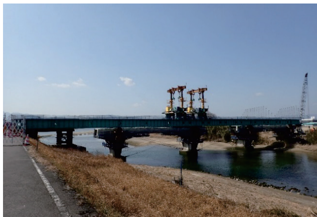
写真-2 架設桁と移動式門構
