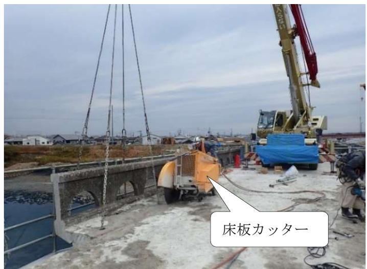
写真-2 高欄・張出床板切断状況
