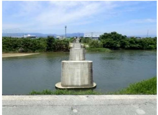
写真-13 ゲルバー桁撤去完了
