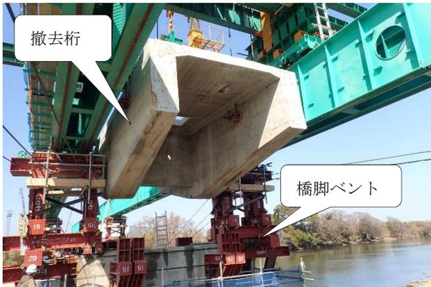
写真-5 撤去桁吊上げ
