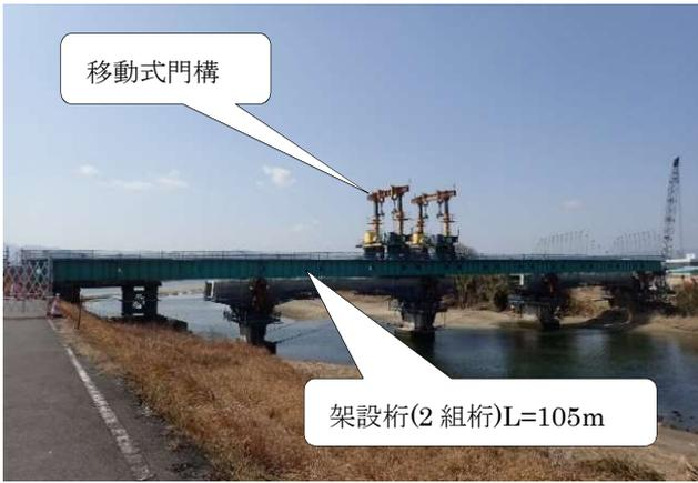
写真-3 架設桁と移動式門構
