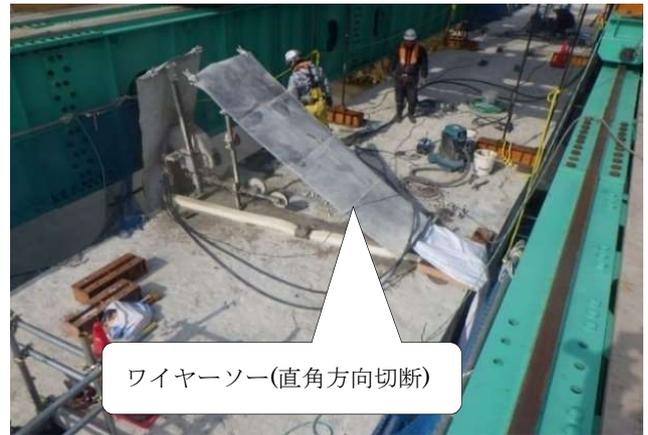
写真-4 撤去桁のワイヤーソー切断
