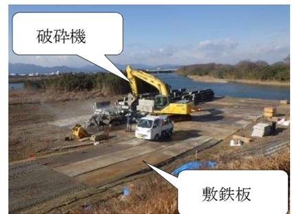
写真-13 破砕ヤードの鉄板養生
