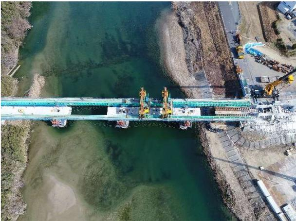
写真-12 ゲルバー桁撤去全景
