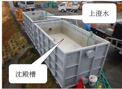
写真-12 切断水の回収と循環利用
