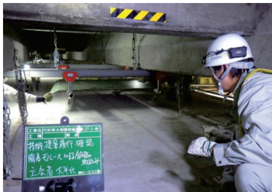
写真-2 モノレール設置状況
