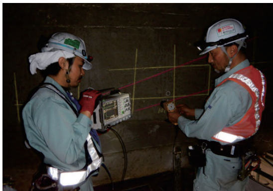
写真-1 インパクトエコー法による調査状況
