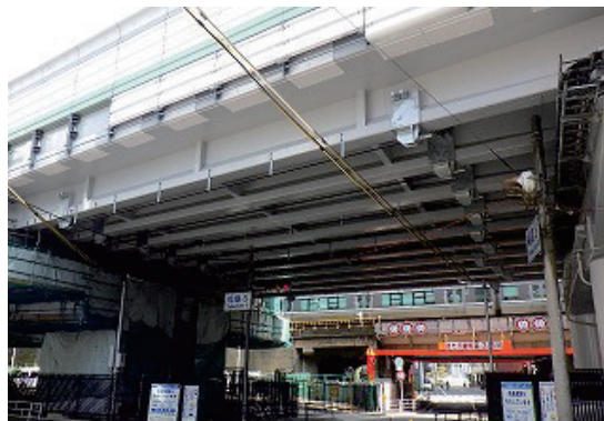
写真-3 外ケーブル補強
