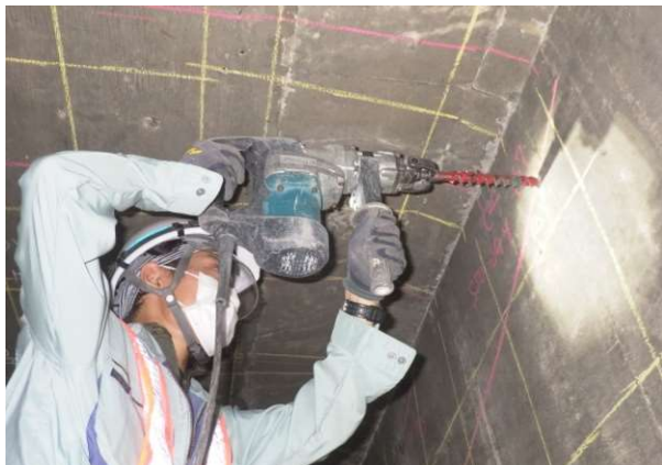
写真-5 シース位置削孔状況
