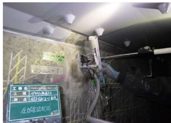
写真-20 注入後圧力確認
