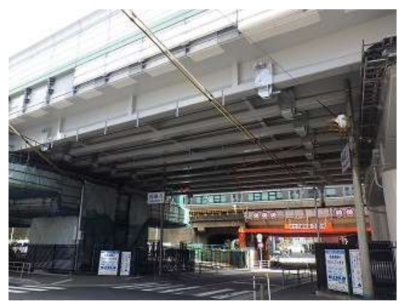
写真-16 外ケーブル補強(完成)
