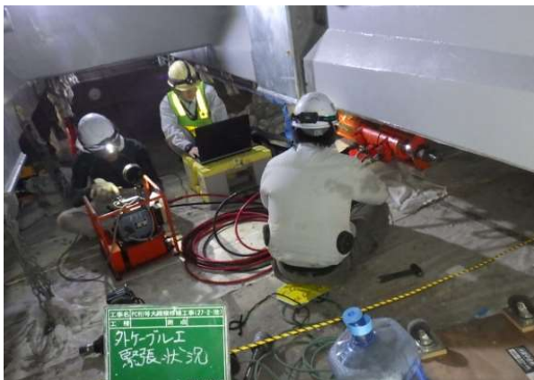
写真-15 外ケーブル緊張状況
