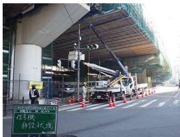
写真-2 架空線移設状況の一例（信号移設）
