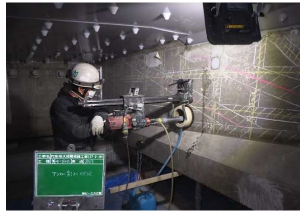
写真-12 削孔状況
