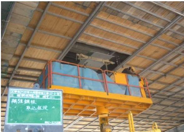
写真-7 鋼板取込状況
