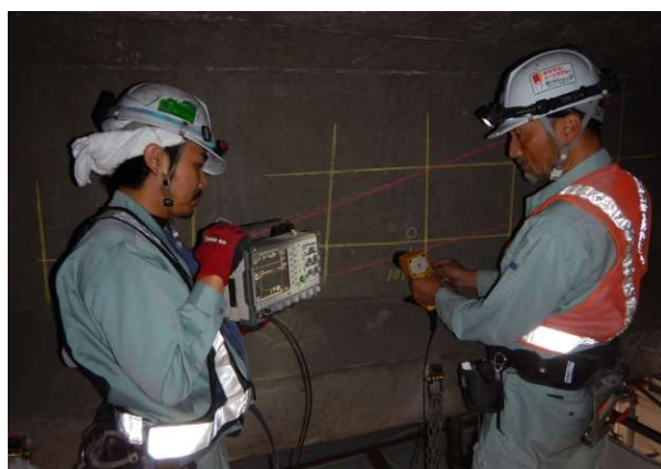
写真-4 インパクトエコー法による調査状況
