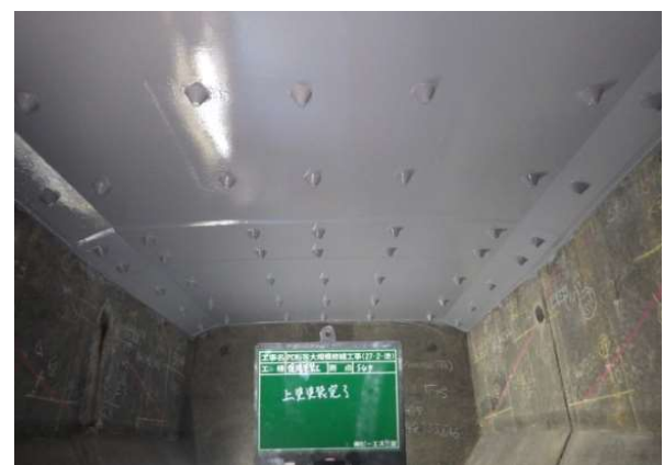
写真-10 鋼板設置完了(塗装完了)
