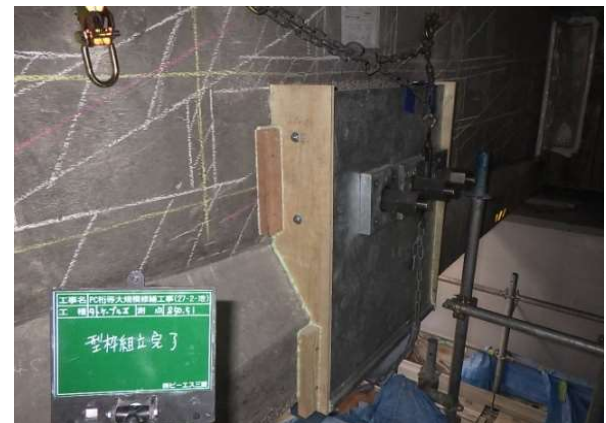
写真-14 型枠組立完了
