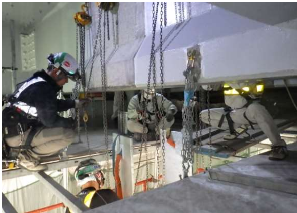
写真-13 ブラケット取込状況
