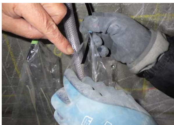
写真-19 グラウト排出確認
