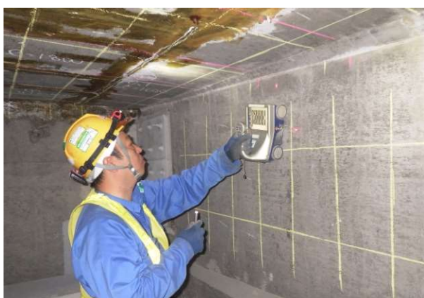
写真-3 ケーブル位置探索状況
