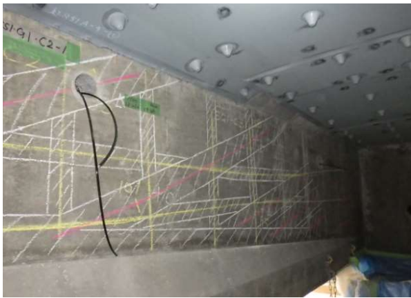
写真-11 削孔前ケーブル探索結果
