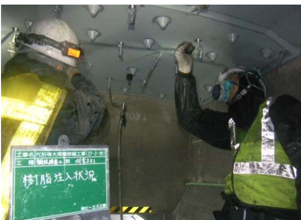
写真-9 注入材注入状況
