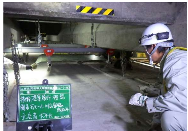
写真-8 モノレール設置状況
