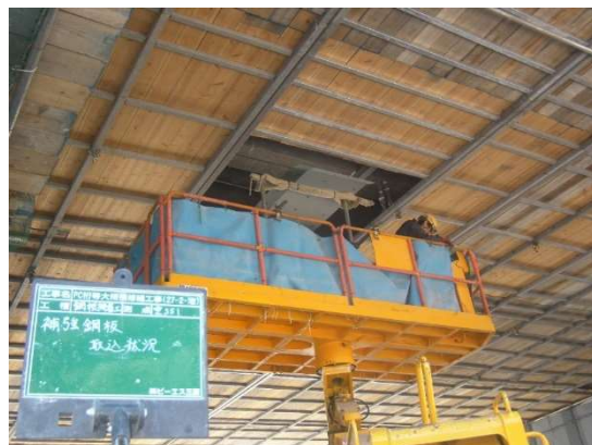
写真-1 鋼板取り込み状況
