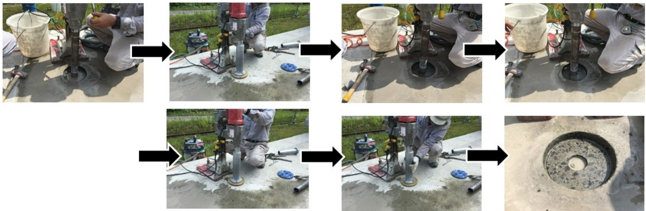
写真-2 水平に研磨版を設置したコアマシンによる方法の施工状況
