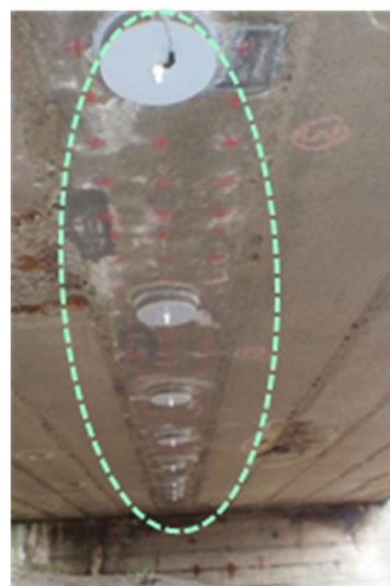
写真-3 PCI 桁への適用事例
