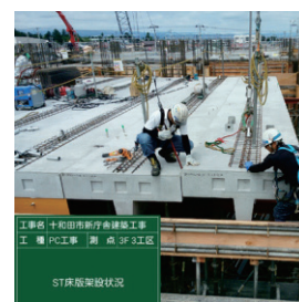
写真-3 架設状況
