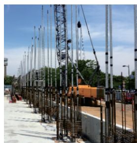
写真-4 PC鋼棒先立て状況
