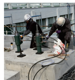
写真-6 PC鋼棒緊張状況
