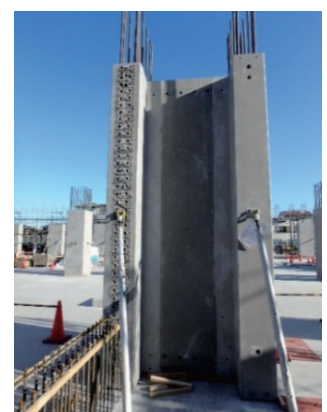
写真-2 H型柱建て方状況
