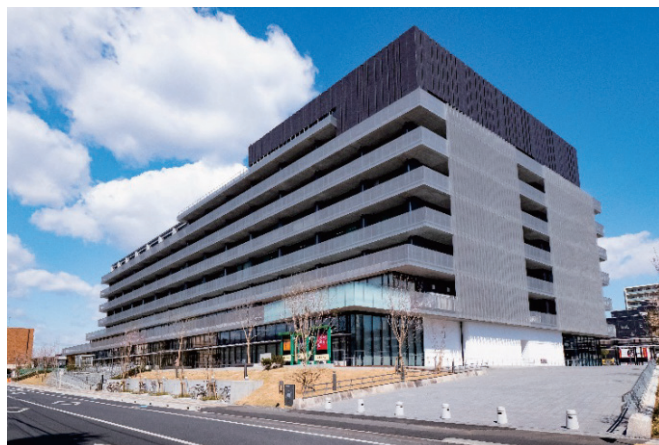
写真-1 建物外観
