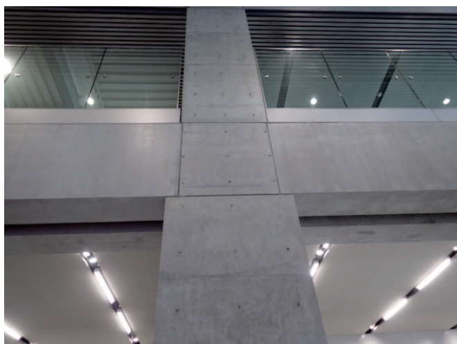
写真-3 柱-スパン梁取り合い目地
