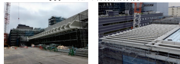
写真-3 PCaPC 部材架設完了
