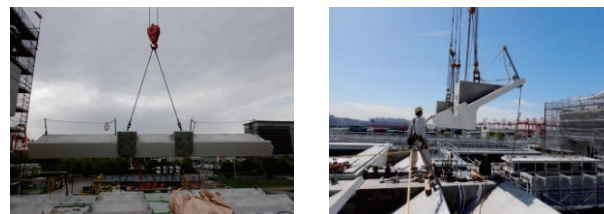
写真-2 PCaPC 部材架設状況
