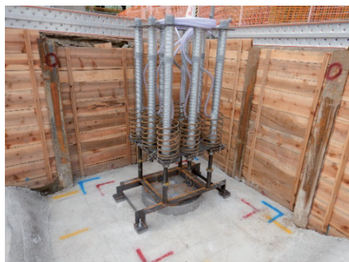
写真-2 アンカーフレーム施工状況
