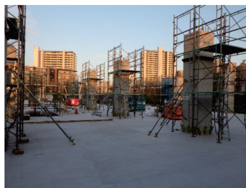
写真-3 PC柱用足場状況
