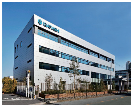
写真-1 建物全景
