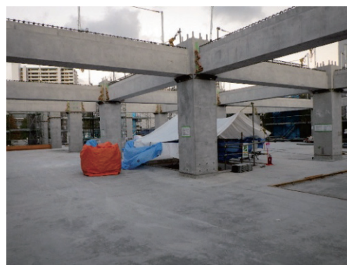
写真-4 柱・梁架設状況
