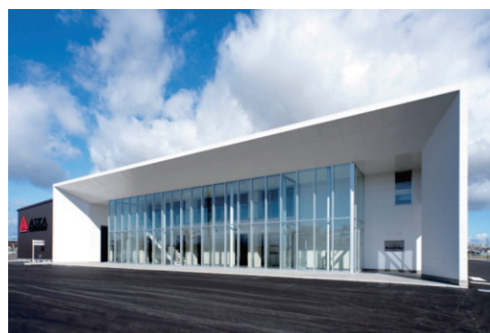
写真-5 外観 (ナレッジパーク)
