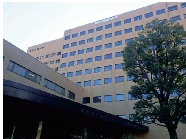
写真-1 建物外観
