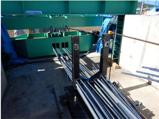
写真-2 PC ケーブル挿入状況
