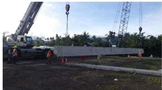
写真-5 桁取り出し状況
