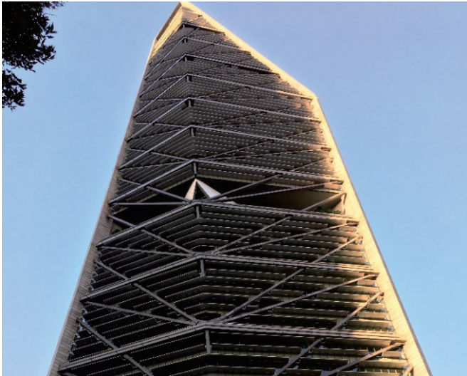
写真-2 Torre Reforma.
