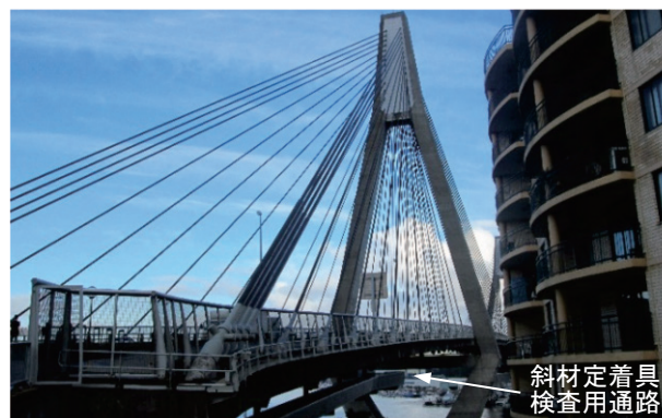
写真-7 アンザック橋全景
