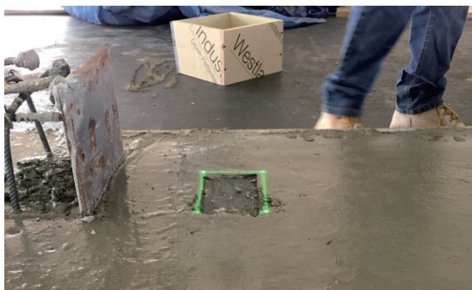
写真-5 レーザー照射状況
