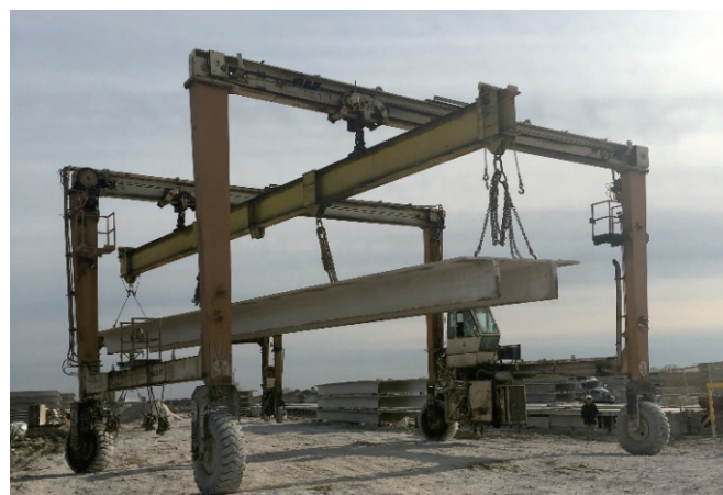
写真-7 場内部材運搬状況
