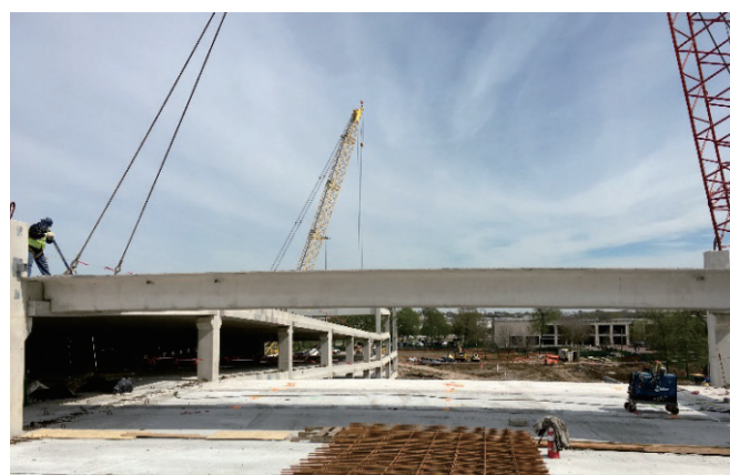
写真-8 現場状況
