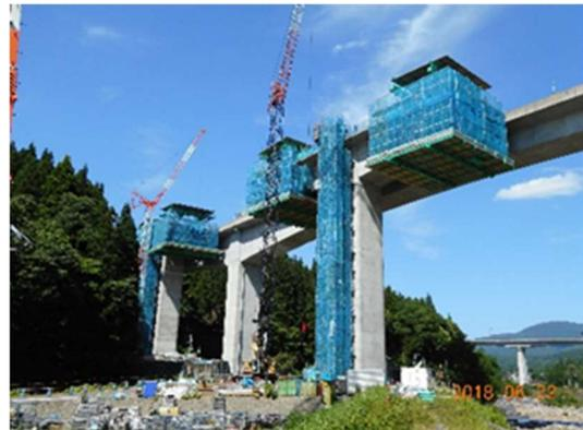
写真-8 張出し施工状況
