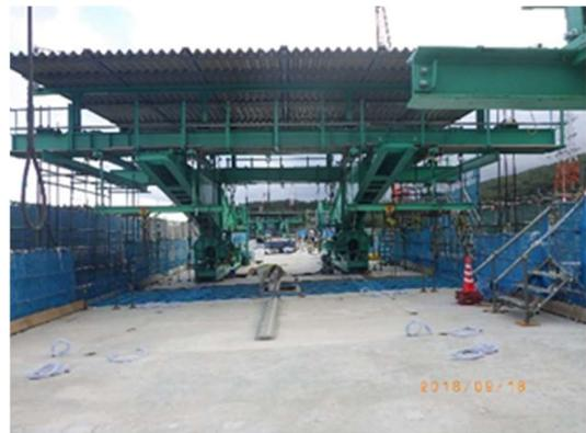
写真-10 閉合部施工状況
