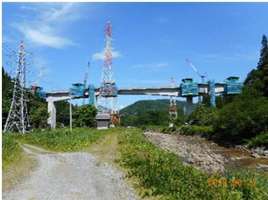
写真-7 張出し施工状況
