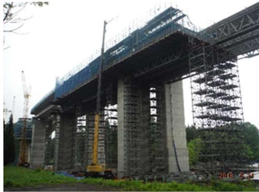
写真-6 支保工先行施工
