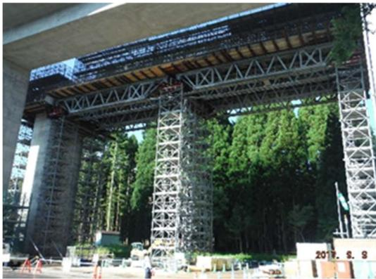
写真-5 トラス梁設置状況
