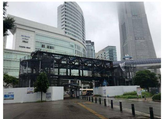
写真-5 25m スパン梁架設状況④
