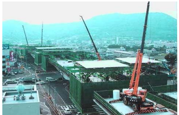
写真-5 場所打ち張出し架設工法
