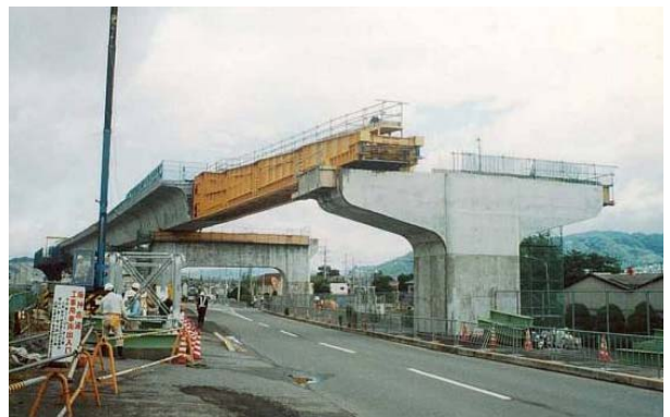
写真-4 押し出し架設工法
