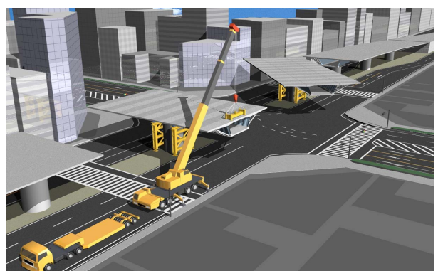
写真-7 回転架設工法
