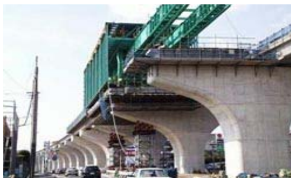
写真-3 移動式支保工架設
