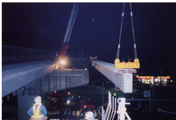
写真-1 トラッククレーン架設
