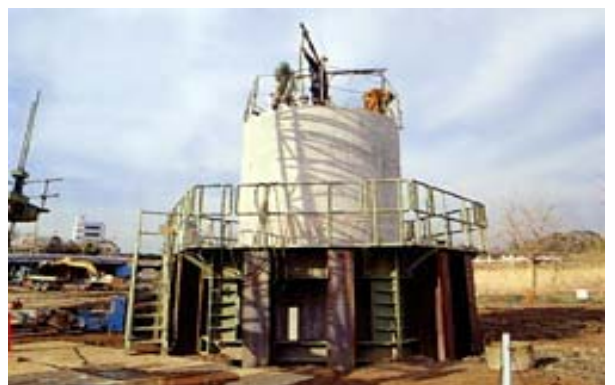
写真-11 PCウェル工法
