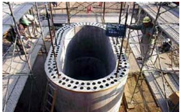
写真-9 プレキャスト橋脚工法
