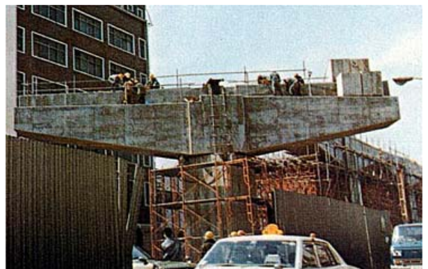
写真-10 回転橋脚工法
