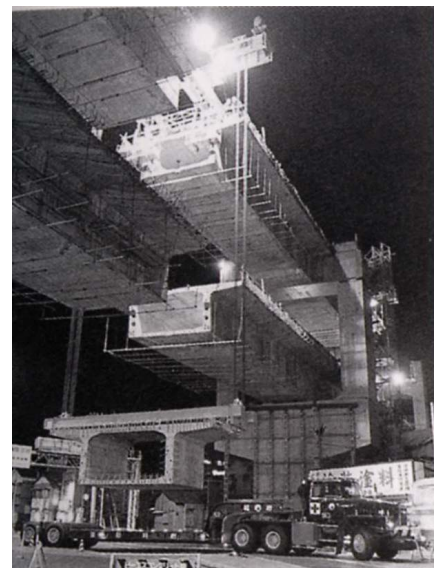
写真-6 バランスドカンチレバー架設
