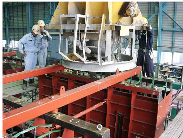
写真-3 打設状況
