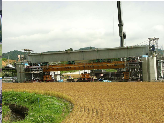
写真-5 架設状況
