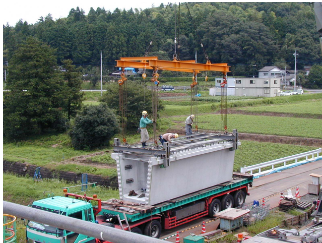
写真-4 架設状況
