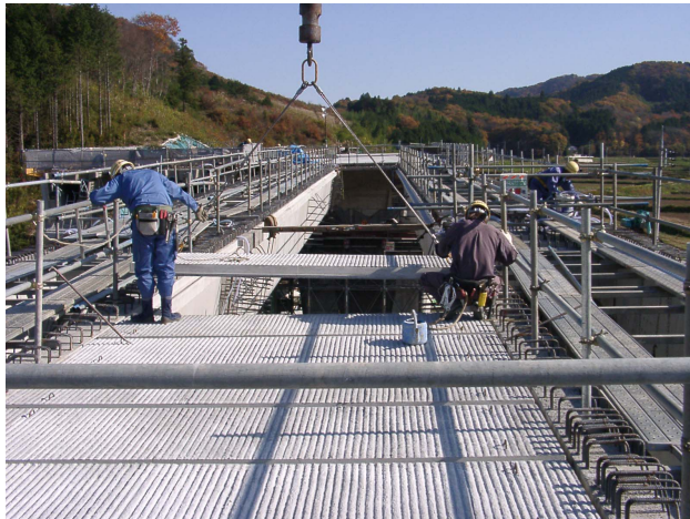
写真-7 PC 板架設状況
