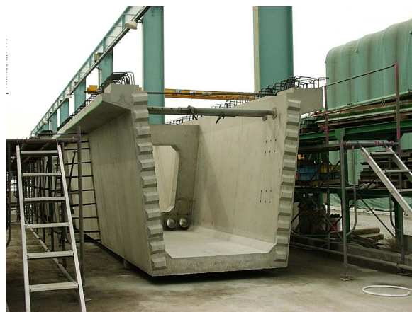
写真-2 セグメント仮置き状況
