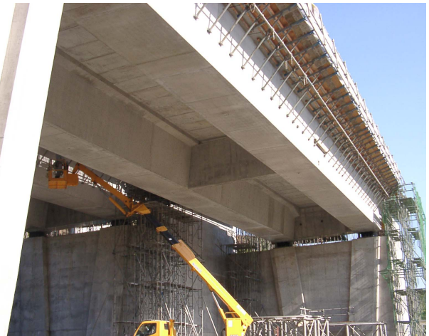
写真-8 張出し床版施工用ブラケット
