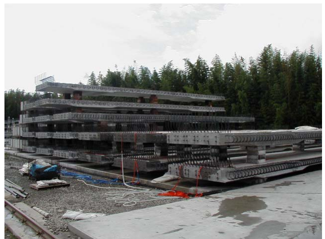
写真-2 養生およびストック状況
