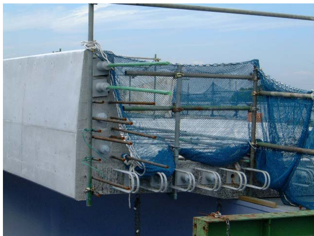
写真-3 中央分離帯の補強状況 (県道上)
