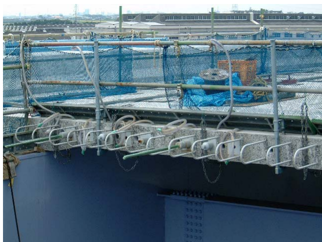
写真-5 床版の補強状況 (県道上)
