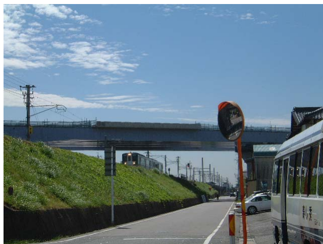
写真-6 送り出し架設完了 (愛知環状鉄道上)
