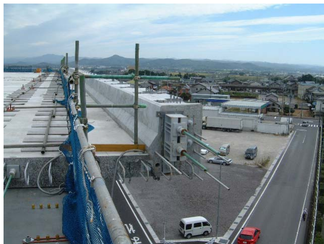
写真-4 壁高欄の補強状況 (県道上)
