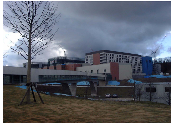
写真-1 建設中の総合研究棟方面を望む
