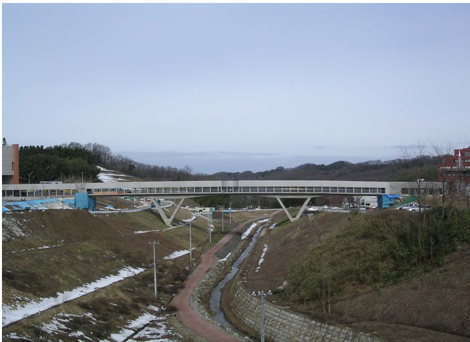
写真-2 南側より側面を望む地形状況
