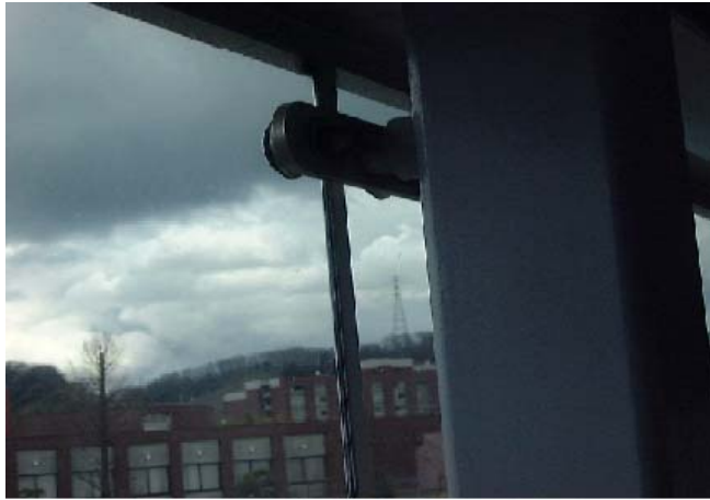
写真-4 ガラス取り付け状況
