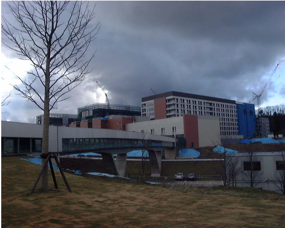
写真-1 建設中の総合研究棟方面を望む
