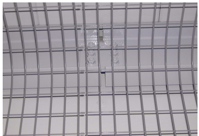
写真-3 上屋鉄骨部伸縮部
