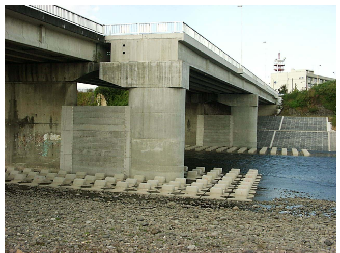
写真-5 完成状況全景
