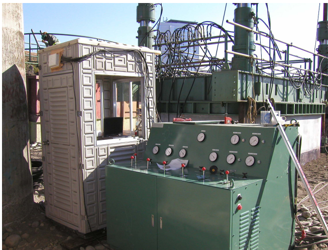
写真-3 圧入管理装置
