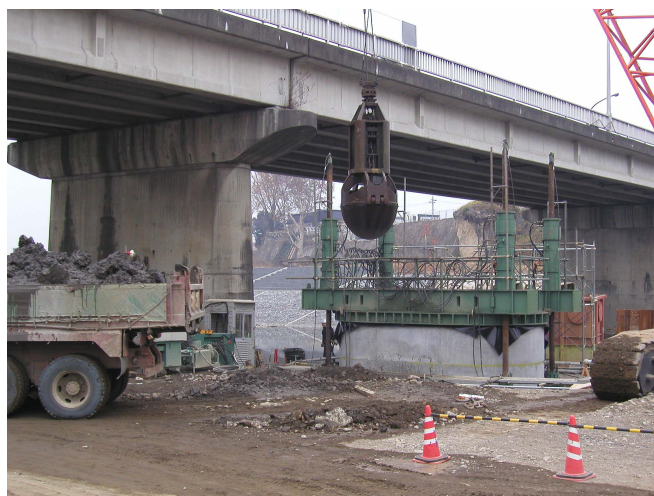
写真-1 圧入掘削状況
