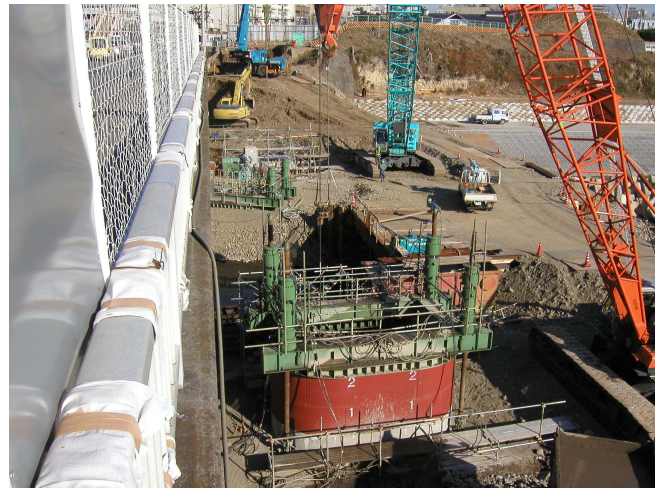
写真-4 鋼製セグメントによる圧入状況
