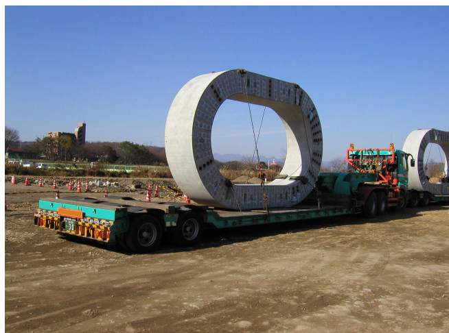
写真-2 基礎ロット搬入
