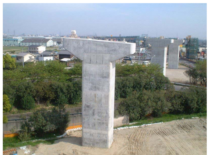
写真-1 施工完了状況
