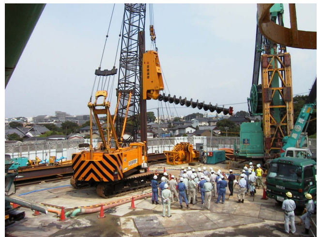
写真-1 地中連続壁・すかし掘り工 すかし掘り部掘削機
